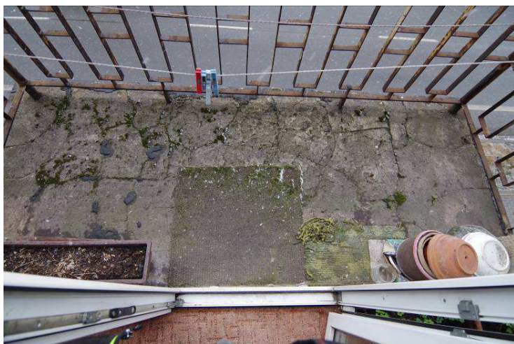
8-9) ul. 1. máje vchod 462, horní balkón 1. Horní povrch porušený smršťovacími trhlinami, který je již silně degradován, obnažená hydroizolace
