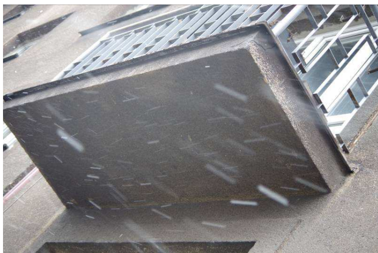
10-11) ul. 1. máje vchod 462,. porucha trhlinami v omítce na rohu balkonu - pohled a detail poruchy
