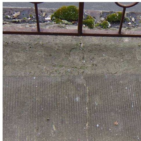
4-5) ul. 1. máje vchod 394, horní balkón. Horní povrch porušený smršťovacími trhlinami, který je již degradován, obnažená hydroizolace
