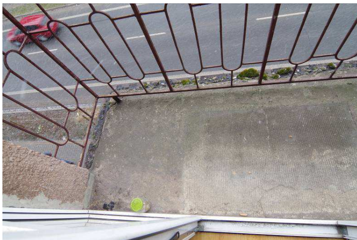
4-5) ul. 1. máje vchod 394, horní balkón. Horní povrch porušený smršťovacími trhlinami, který je již degradován, obnažená hydroizolace
