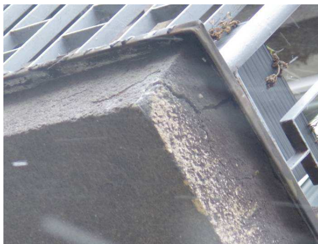
10-11) ul. 1. máje vchod 462,. porucha trhlinami v omítce na rohu balkonu - pohled a detail poruchy
