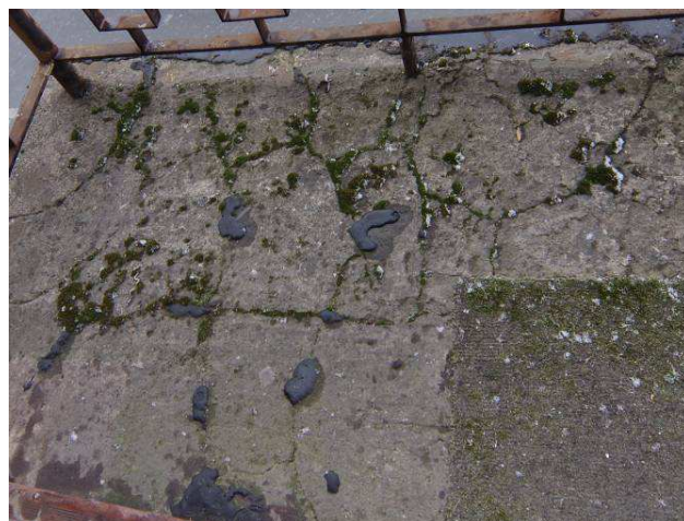
8-9) ul. 1. máje vchod 462, horní balkón 1. Horní povrch porušený smršťovacími trhlinami, který je již silně degradován, obnažená hydroizolace
