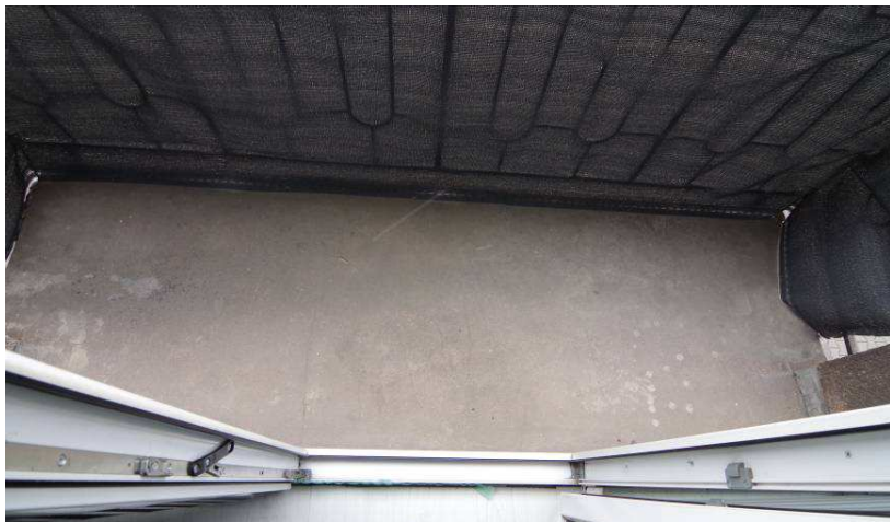
2-3) ul. 1. máje vchod 393, spodní balkón. Horní povrch porušený smršťovacími trhlinami, který ještě není degradován
