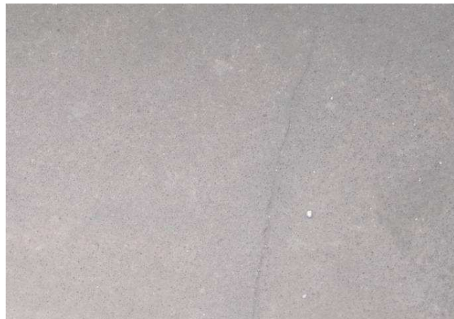
2-3) ul. 1. máje vchod 393, spodní balkón. Horní povrch porušený smršťovacími trhlinami, který ještě není degradován
