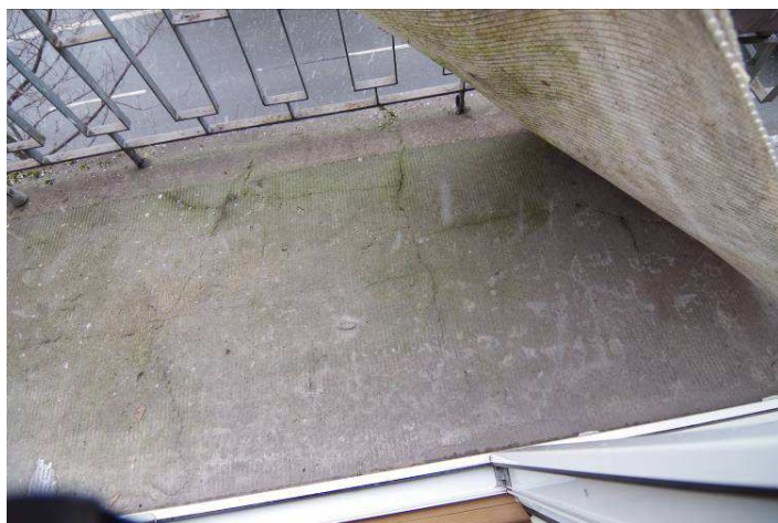
4-5) ul. 1. máje vchod 394, horní balkón. Horní povrch porušený smršťovacími trhlinami, který je již degradován, obnažená hydroizolace
