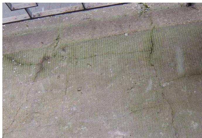
4-5) ul. 1. máje vchod 394, horní balkón. Horní povrch porušený smršťovacími trhlinami, který je již degradován, obnažená hydroizolace
