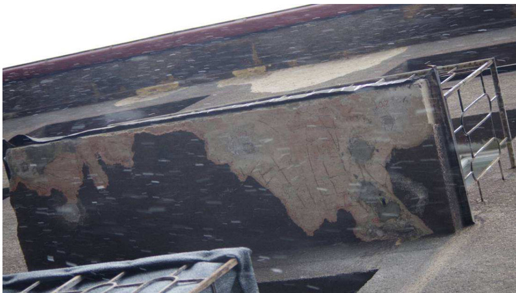
14) ul. 1. máje vchod 393,. obnažená omítka spodního líce a porucha žel.bet. desky v rohu - pohled a detail poruchy
