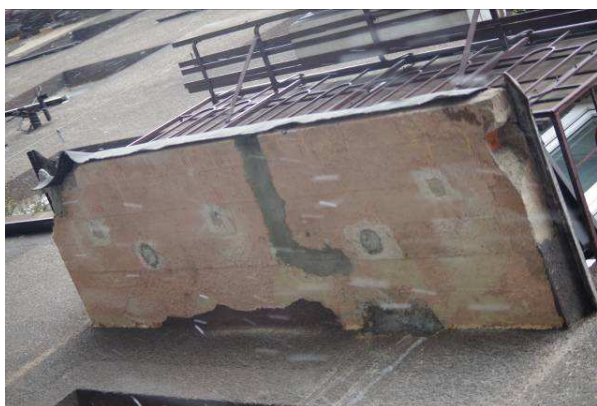
12-13) ul. 1. máje vchod 394,. obnažená omítka spodního líce a porucha žel.bet. desky v rohu - pohled a detail poruchy
