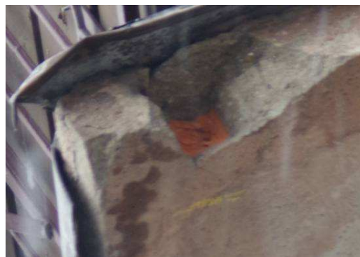
12-13) ul. 1. máje vchod 394,. obnažená omítka spodního líce a porucha žel.bet. desky v rohu - pohled a detail poruchy
